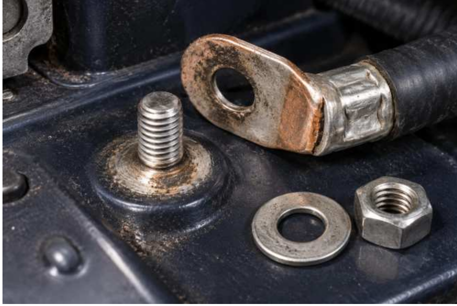
Şekil 2: Şasi saplamasının yanındaki sökülmüş araç dönüş kablosu pabucu; bağlantının altındaki düzensiz temas yüzeyleri görülüyor
