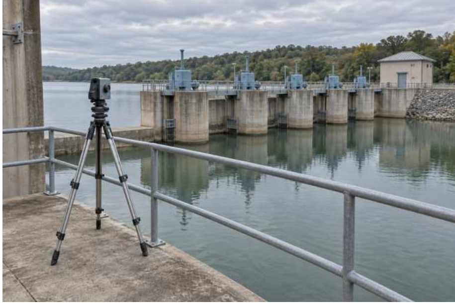
Şekil 1: Teras üzerindeki optik kontrol cihazı, baraj gölü karşısındaki benzer çıkış kapaklarına bakıyor; pompa binası belirgin bir referans oluşturuyor
