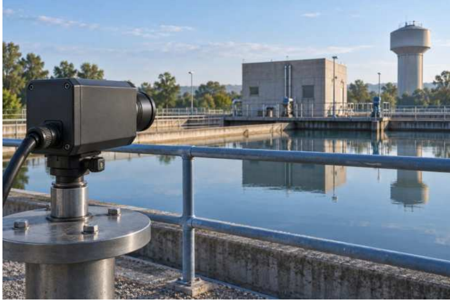
Şekil 1: Bir su arıtma tesisindeki inceleme kamerası; yakındaki korkuluğa, pompa binasına ve uzaktaki su kulesine bakıyor
